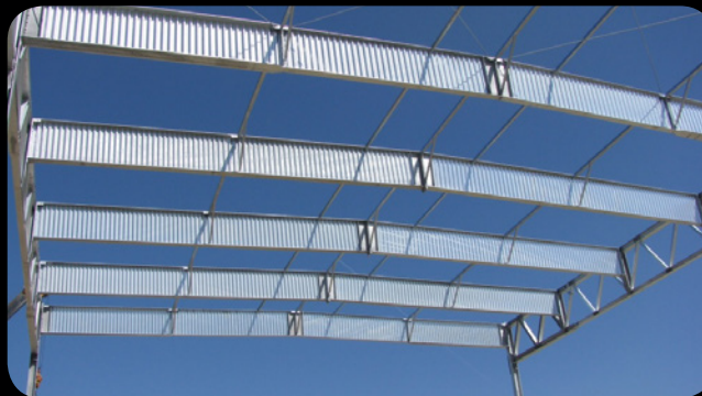
Fot. 7. Konstrukcja hali z profili SIN
